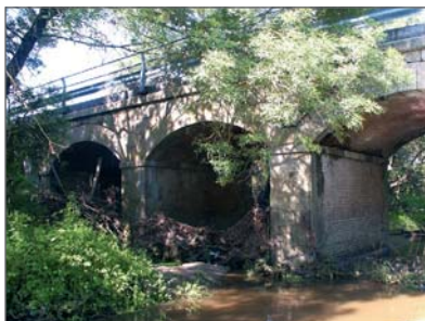
Puente de las Encinas Altas
